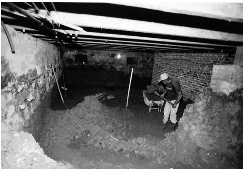
Figura 40 - Retirada de terra do porão, 2002. 128
