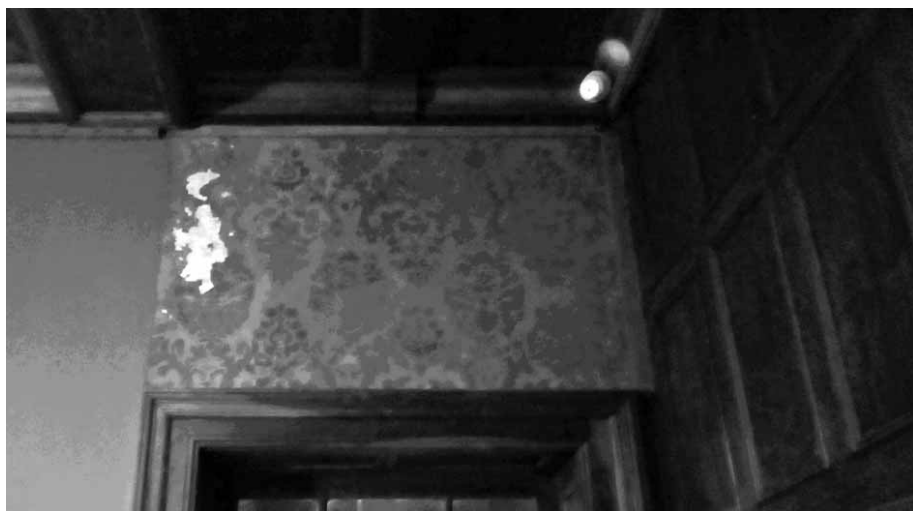
Figura 45 - Detalhe na Sala São Francisco, 2018. 133
