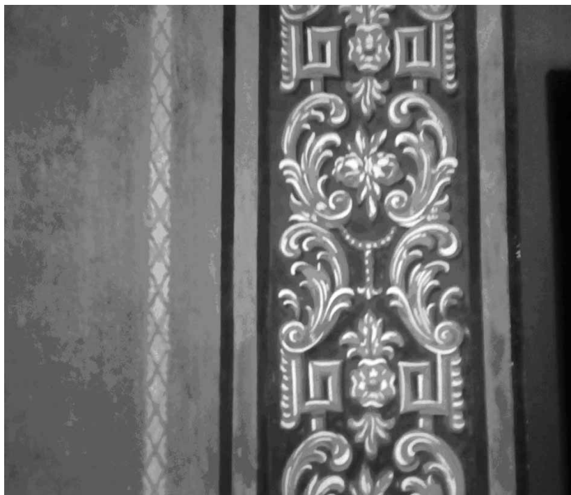
Figura 51 - Detalhe pintura recuperada do corredor do pavimento superior, 2018. 140
